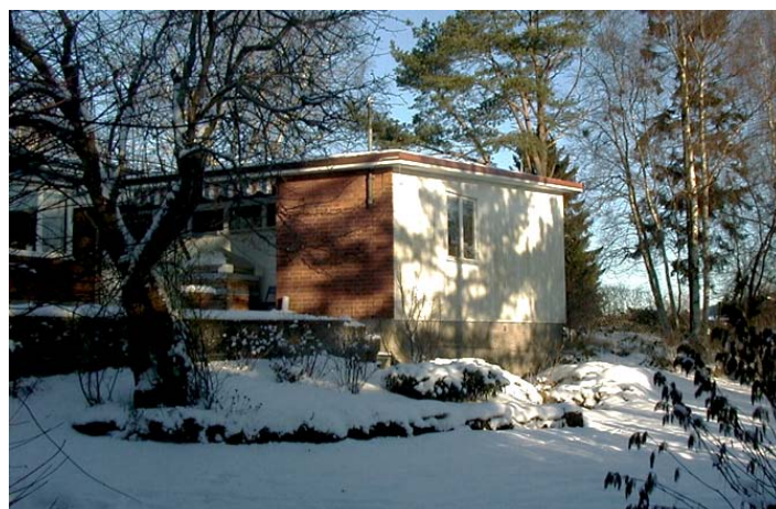
Gaveln på det vidbyggda garaget där tillbyggnad är tänkt placeras.
